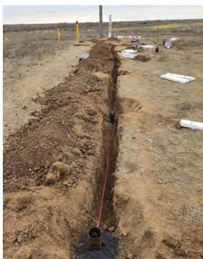
Рис. 4. Монтаж анодов в сваи
