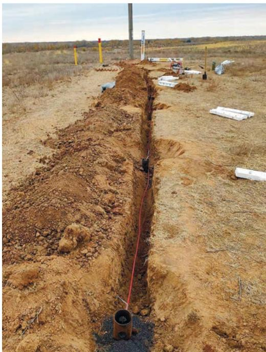
**Рис. 3. Монтаж вертикальных анодных заземлений**
